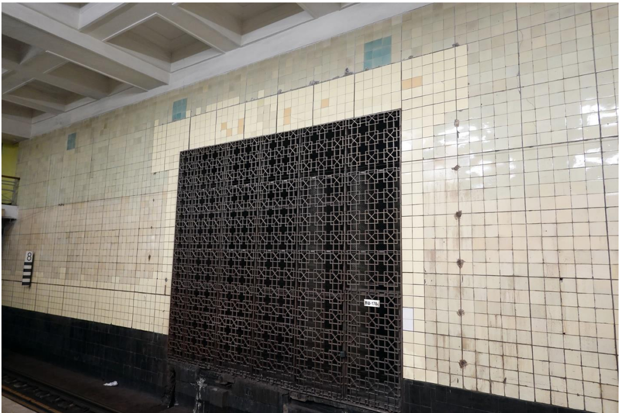
Вентиляционная шахта на станции метро Сокольники 1935 года
